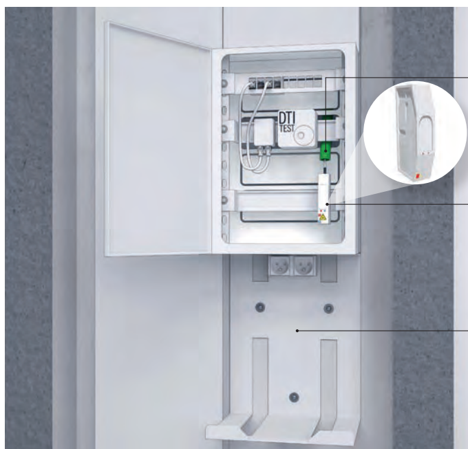
Fig. 37 | Arrivée du kit DTIo et son installation dans le TC
